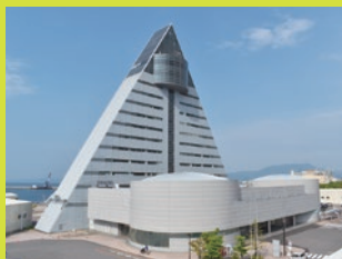
w-2 青森県観光物産館アスパム (60分 10.0km)
